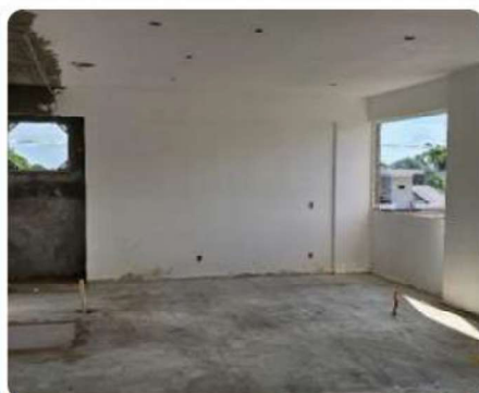
Foto 3 - Execução de contrapiso no tipo 02.
