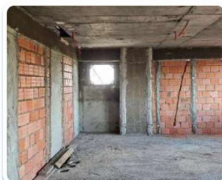
Foto 6 - Execução e marcação de rasgos para infraestrutura elétrica.
