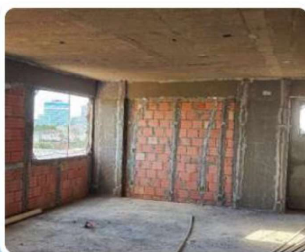
Foto 5 - Aplicação de chapisco no teto com rolo.
