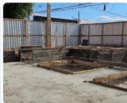
Foto 2 - Armações da piscina posicionadas.
