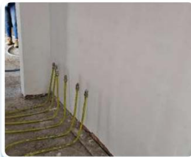
Foto 4 - Instalação de tubulação de gás.
