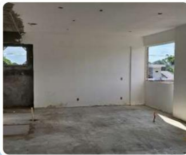
Foto 3 - Execução de contrapiso no tipo 02.
