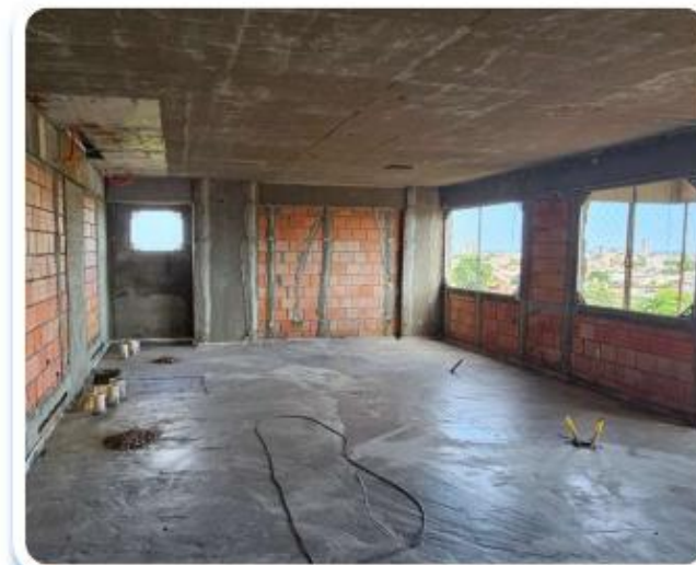
Foto 8 - Contrapiso e contramarco no 8º pavimento.
