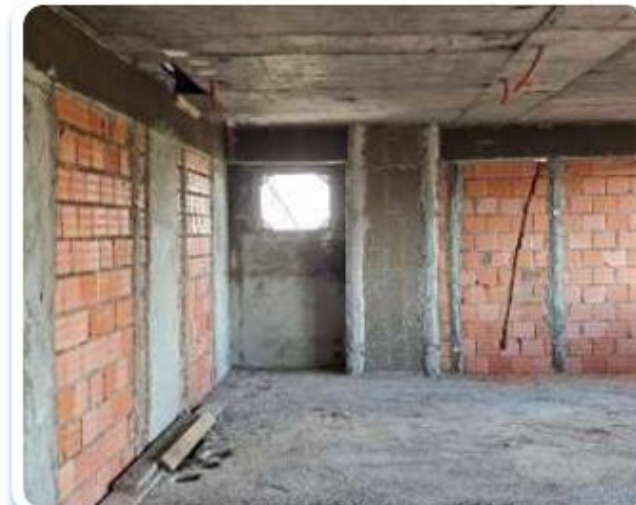
Foto 6 - Execução e marcação de rasgos para infraestrutura elétrica.
