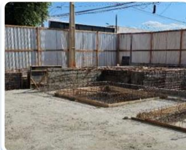
Foto 2 - Armações da piscina posicionadas.
