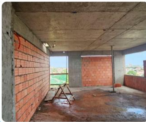
Foto 7 - Alvenaria no décimo primeiro pavimento.
