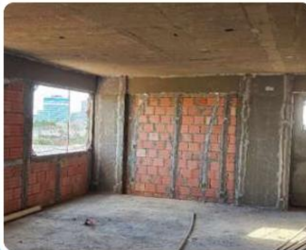
Foto 5 - Aplicação de chapisco no teto com rolo.
